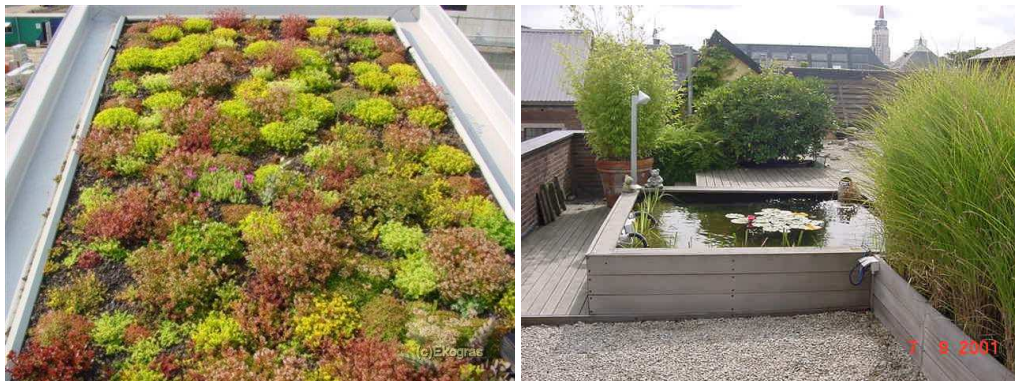
Een extensief en een intensief groendak (Bron: ekogras en construmat)
