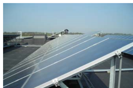
Modules PV polycristallins en toiture
