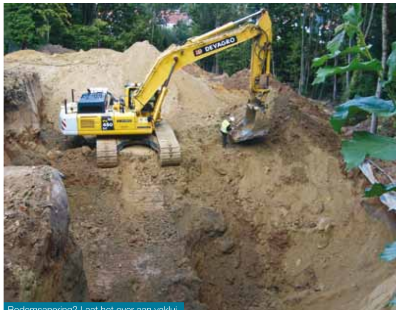
Bodemsanering? Laat het over aan vaklui.
