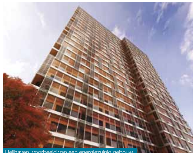
Helihaven, voorbeeld van een energiezuinig gebouw.
