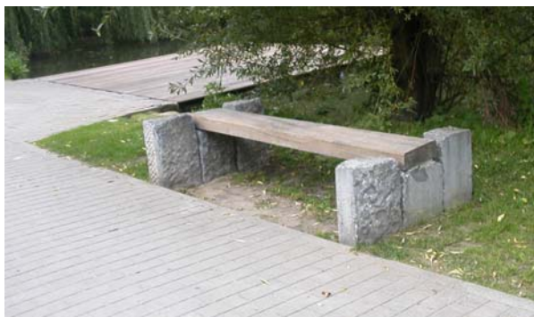
Watermaal: hergebruik van boordstenen voor een bank
