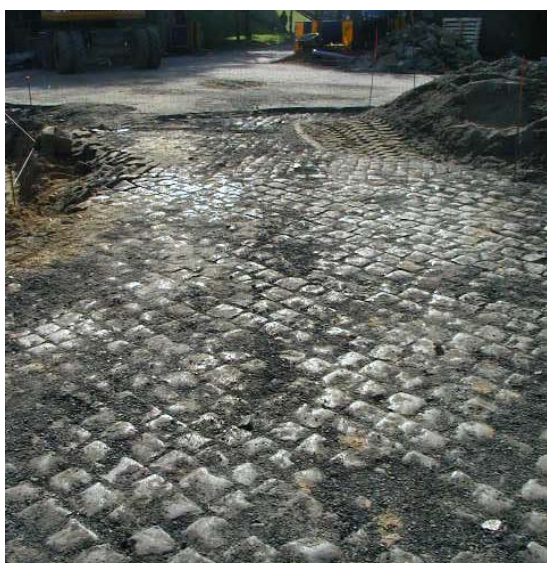
Watermaal: demontage van porfieren onder asfalt en hun hergebruik
